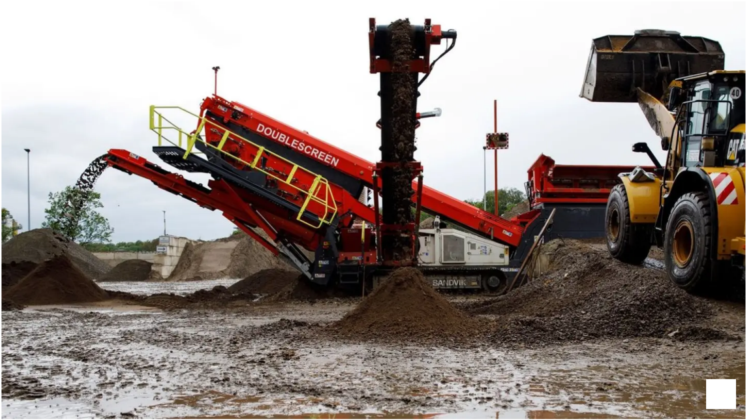
Bodenaufbereitung am Piesberg. FOTO: DAVID EBENER
