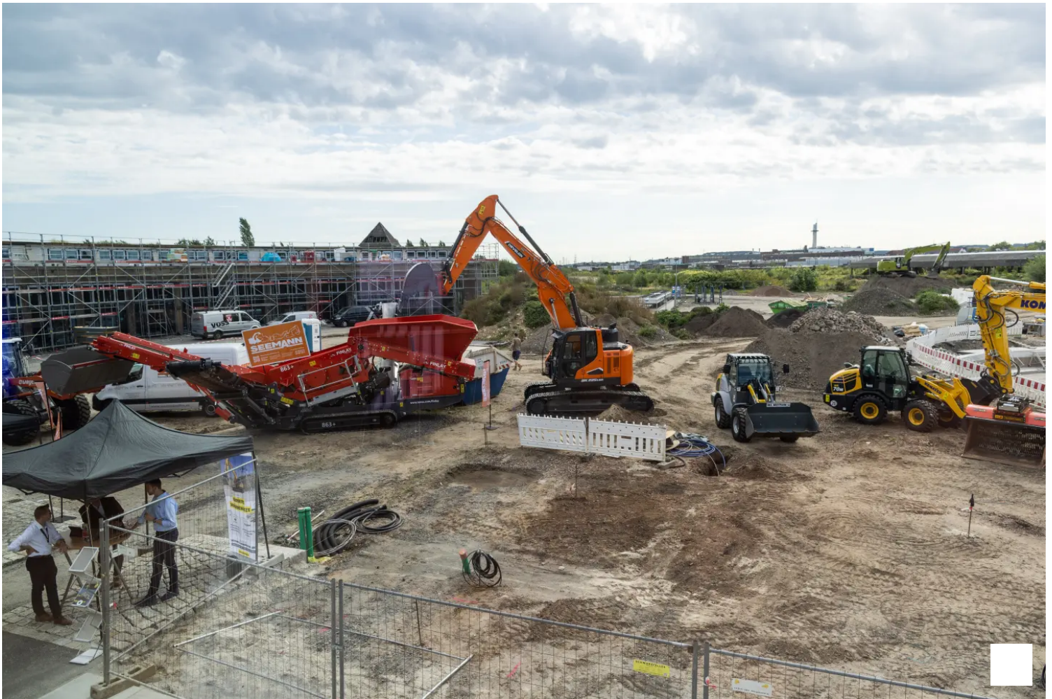
Tagung auf der Baustelle: Blick vom Ringlokschuppen auf den Güterbahnhof. FOTO: MICHAEL GRÜNDEL
