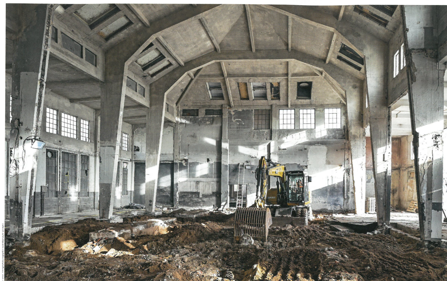
Der Mittelbau des Ringlokschuppens während der Bauarbeiten
